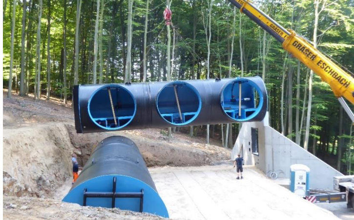
Hochbehälter – Ansicht von Westen
